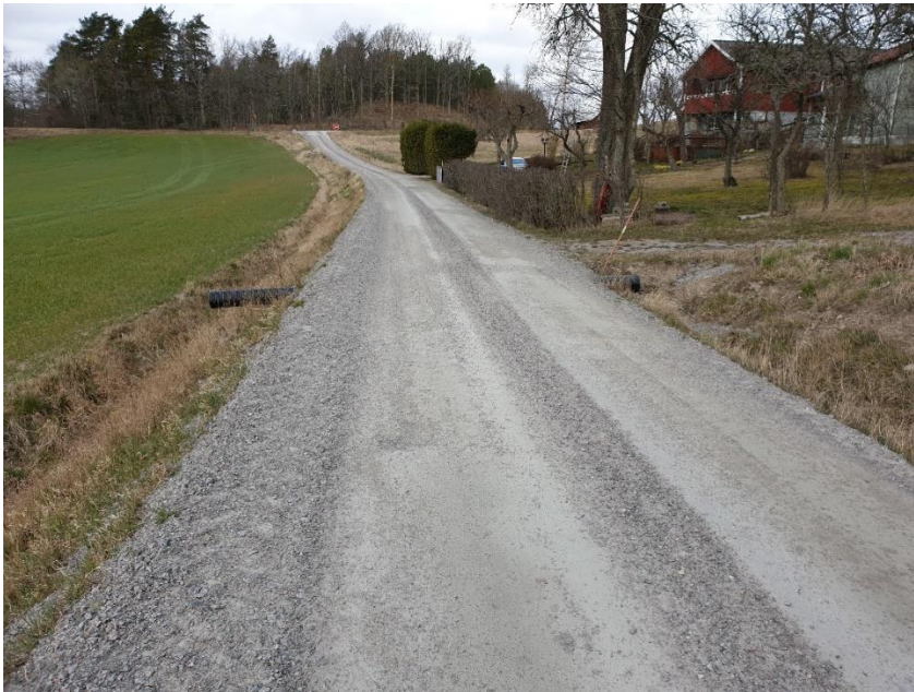
Figur 12. Befintlig trumma under grusvägen längs den norra plangränsen.
